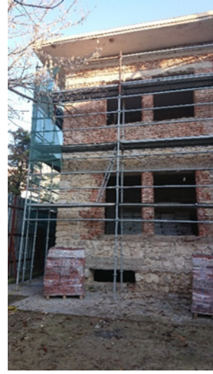
Şekil 34 Güney Cephesi 4.01.2023 Hatipoğlu
