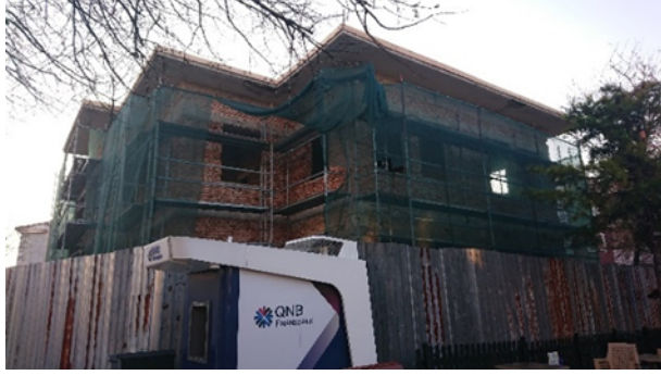
Şekil 33 Batı Cephesi, 4.01.2023 Hatipoğlu
