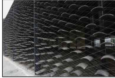
Görsel 14. Kengo Kuma and Associates . Çin SanatAkademisi Halk Sanatları Müzesi. 2015, Hangzhou/Çin. Paslanmaz çelik ip gergi sistemi ile sabitlenen birimlere bakış.
