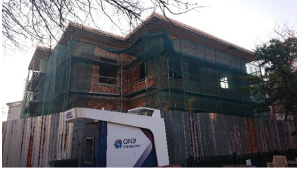
Şekil 33 Batı Cephesi, 4.01.2023 Hatipoğlu
