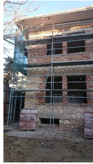
Şekil 34 Güney Cephesi 4.01.2023 Hatipoğlu
