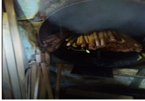
Resim 1. Buhar kazanında fındık ağacı dalları
